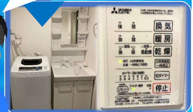
洗濯機 浴室乾燥機
